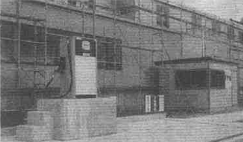
アイティーエスの新社屋(28日のオープンに向け急ピッチで準備が進んでいる。手前はA重油配送センター)
